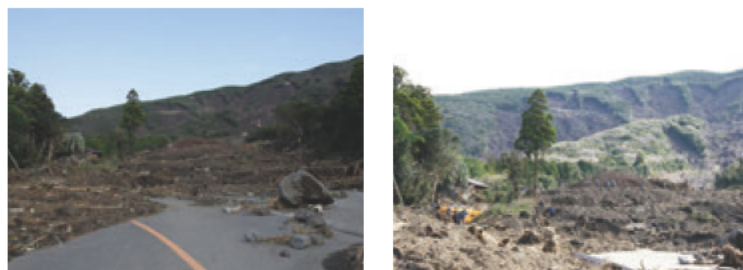
2013年 第26號颱風引起的伊豆大島山體滑坡災害
