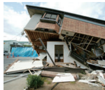
設置了抗震掩體的木制住宅遭遇地震後的倒塌情形
